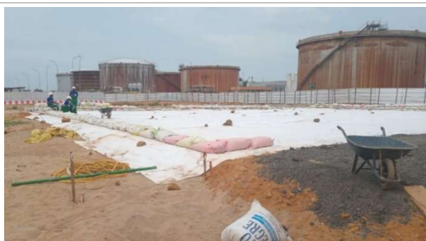
Décapage et stockage des terres polluées avant évacuation
