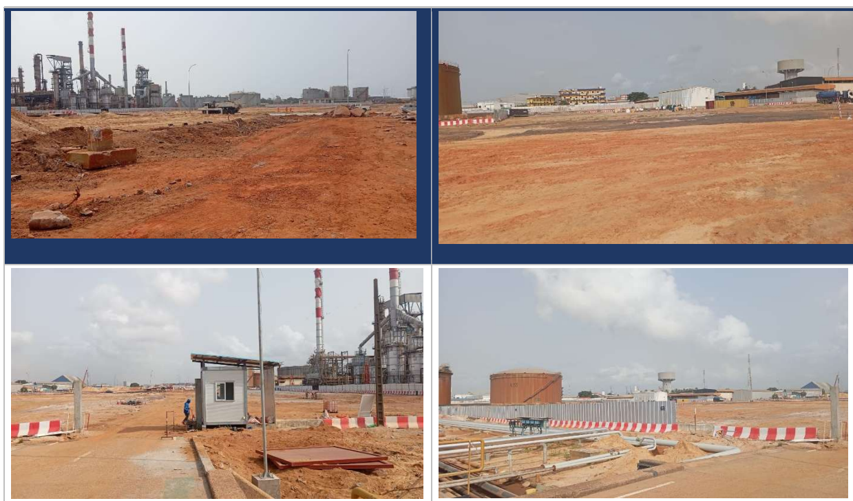
Planche 2 : Images du site du projet après démolition
