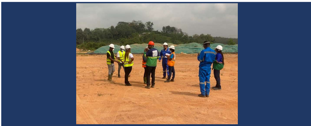
Photo 1 : Stockage des terres pollués sur le site de Thomasset
