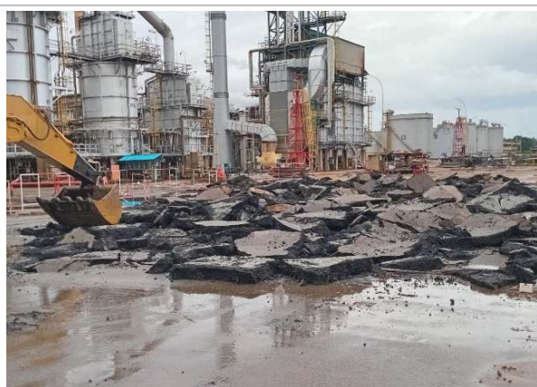
Décaissement bitume espace fluor (AMH)
