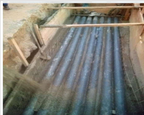
Construction du monolithe pour la traversée de l'avenue G
