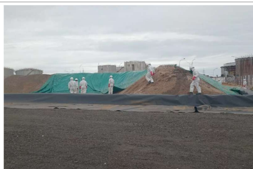
Décapage et stockage des terres polluées avant évacuation
