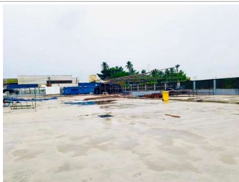
Construction du nouveau parc à déchets
