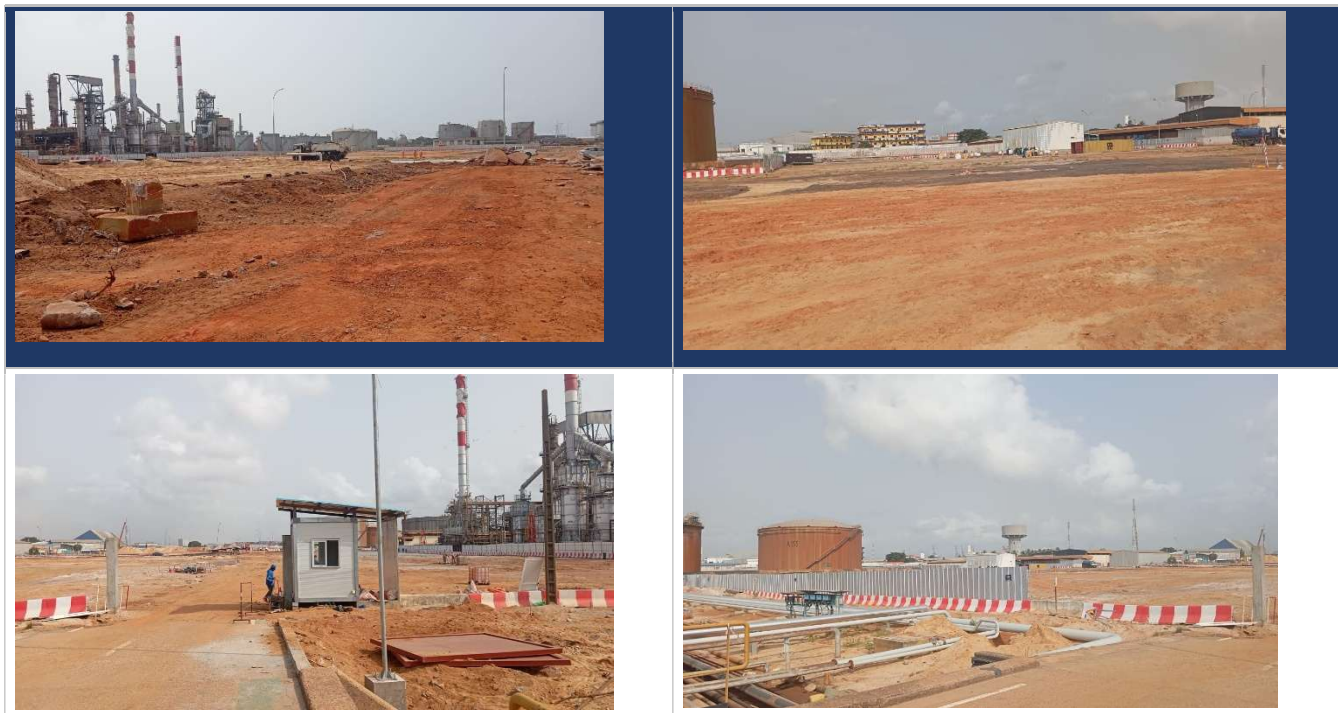
Planche 4 : Images du site du projet après démolition Source : Cabinet ALICA, février 2026
